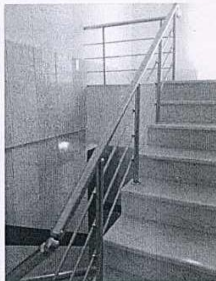
شکل ۱۹- استاندارد نبودن ارتفاع نرده دست انداز پله (کمتر از ۰/۹ متر است) و فاصله قیدها بصورت افقی و بیشتر از ۰/۱۱ متر می باشد.
