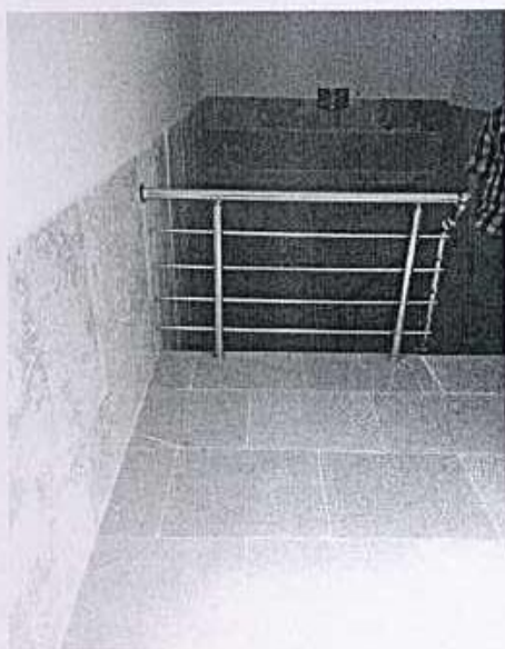
شکل ۱۹- استاندارد نبودن ارتفاع نرده دست انداز پله (کمتر از ۰/۹ متر است) و فاصله قیدها بصورت افقی و بیشتر از ۰/۱۱ متر می باشد.
