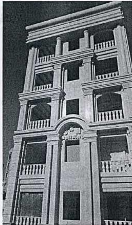
شکل ۱۶- نمای پروژه با احجام و پیش آمدگی بیش از حد مجاز و استفاده از صراحی و ایمن نبودن نرده سنگی از لحاظ ارتفاع و اتصال به سازه اصلی، که نیازمند اتخاذ تدابیر مناسب می باشد.
