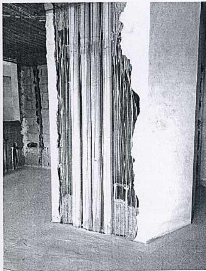
شکل ۱۰- تخریب دیوارها جهت عبور لوله های تاسیساتی
